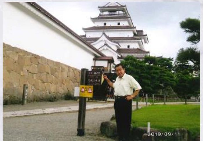
鶴ヶ城 (会津若松城)・福島県会津若松市
